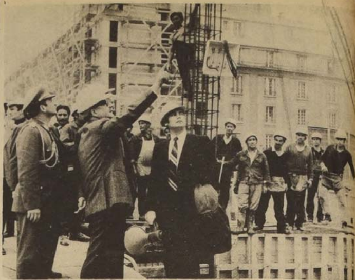
Con el mismo casco que protegen su cabeza los trabajadores, el Presidente Allende recorre las obras del edificio, acompañado del ingeniero de la faena y de su edecán militar, Comandante Mela.
